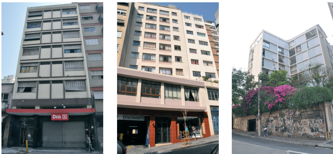
Figura 30. Empreendimentos Centro Vivo Revitalização de Imóveis – Chil Joseph. Edifício Nova Esperança (Rua Rego Freitas); Ed. Miriam (Rua Rego Freitas); Ed. Helena Maria (rua Avanhandava)
