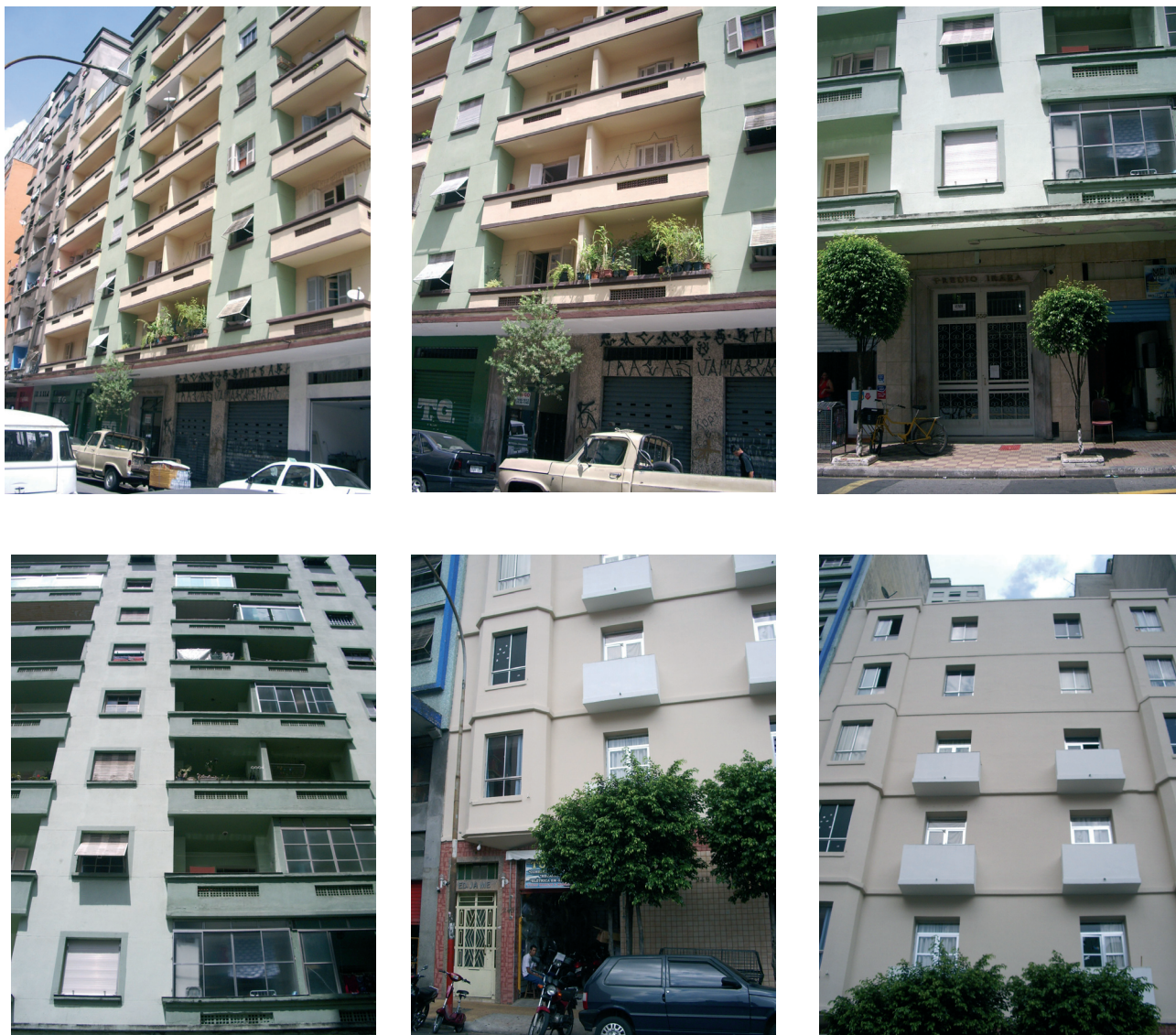
Figura 31. Jaime Romão Empreendimentos Imobiliários. Ed. Guaianases (Rua dos Guaianases); Ed. Irara (Rua Vitória); Ed. Jaime (Rua Cons. Nébias)
